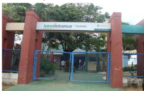
Fig. 1 – Vista de frente da Vila Olímpica do Castelão Fonte (MONICA SOUSA 2010 AUTORA MONOGRAFIA)
