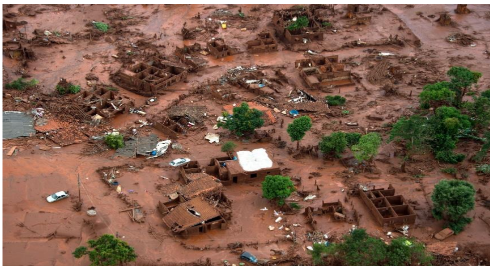
Figura 03: Imagem aérea do distrito de Bento Rodrigues, após o rompimento da barragem de Fundão.
