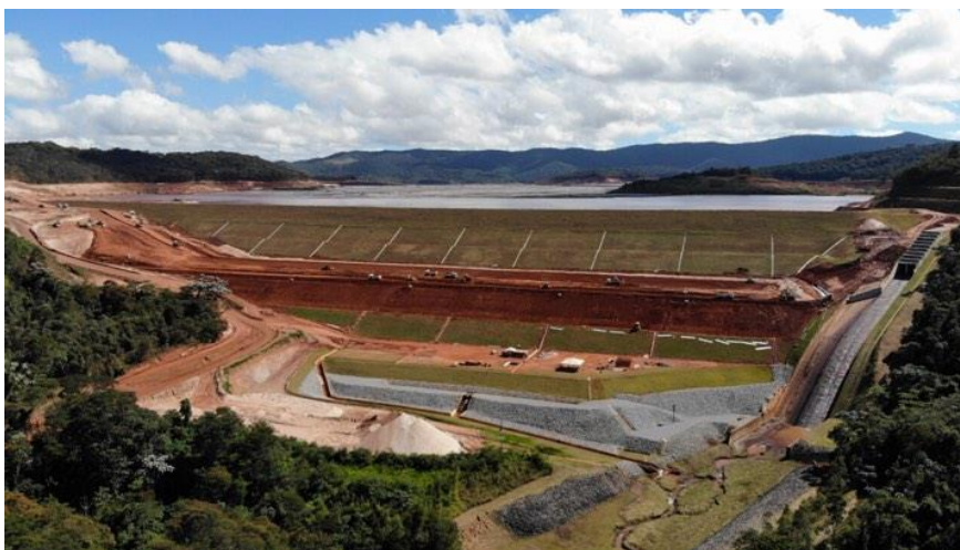
Figura 01 – Alçamento da Barragem Itabiruçu Itabira / MG.
