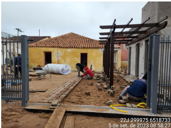
Situação da área do pátio registrada em setembro de 2023, com alterações no solo: retirada e recolocação de paralelepípedo e colocação de camada de aterro de areia
